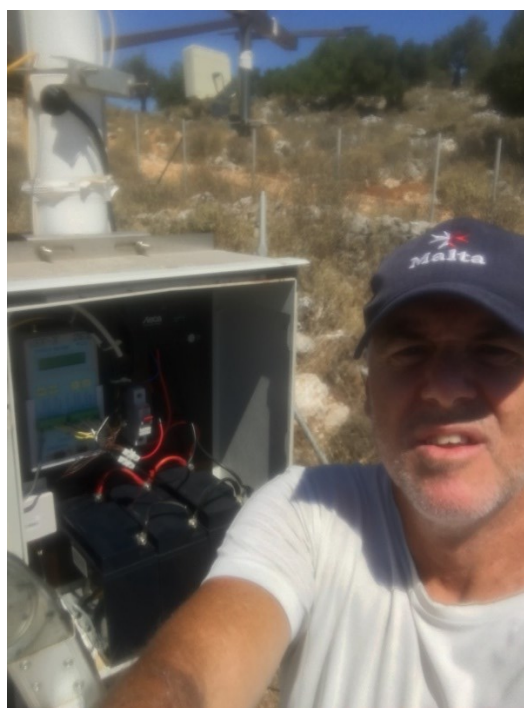
Πάνω και αριστερά: Στιγμιότυπα από τα τεχνικά έργα στον σταθμό ΚΕΦ-3 στα Αποστολάτα Σκάλας-Πόρου (29/8/20).
